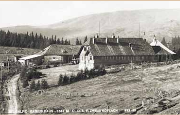
Abbildung 2) links Das Gaberlhaus noch mit altem Stallgebäude. Namensgeber für den Grund, der ihm zu Füßen liegt. Die „Stall- wiesn“. Die Schipiste heißt noch immer so.
